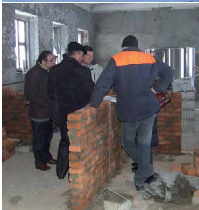
Foto 1. Caseificio aziendale a Veycimir in costruzione.
