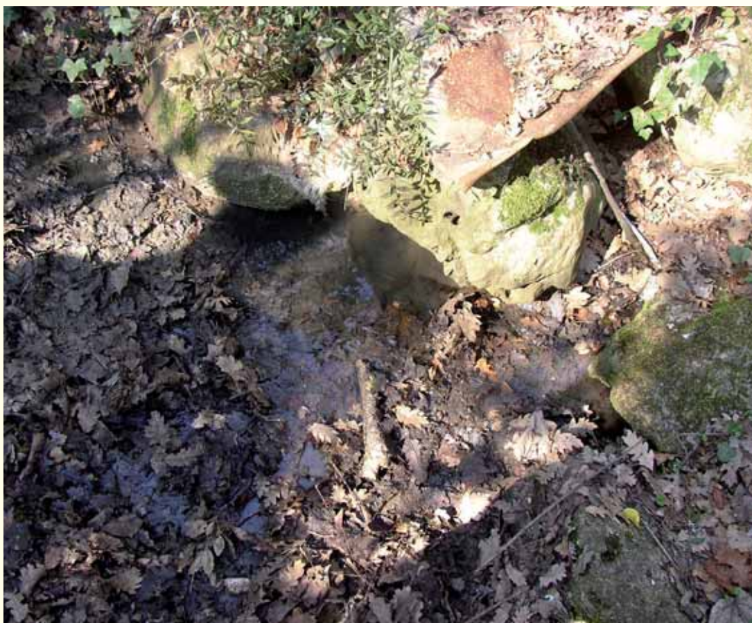
Foto 1. Pozza di acqua stagnante collegata con uno scarico domestico.
