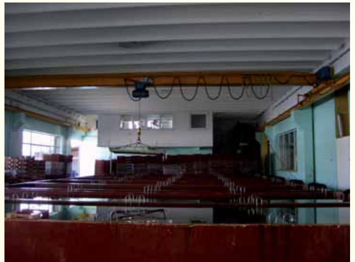
Foto 2. Centro di depurazione mitili, vasche per la depurazione.
